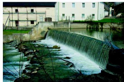
eines Wehrs möglich. Meist sind jedoch kompliziertere Lösungen, wie der Bau einer Fischtreppe oder eines künstlichen Umgehungsbachs, erforderlich. Beispielhaft sei hier ein 4 Meter hohes Mühlenwehr auf der Pielach genannt welches gleich drei Kleinwasserkraftwerke mit Wasser versorgt. Da ein vollständiger Rückbau des Wehrs kommt hier als Option nicht in Frage kommt, ist nun der Bau eines künstlichen, 300-Meter langen Umgehungsbachs erforderlich.
