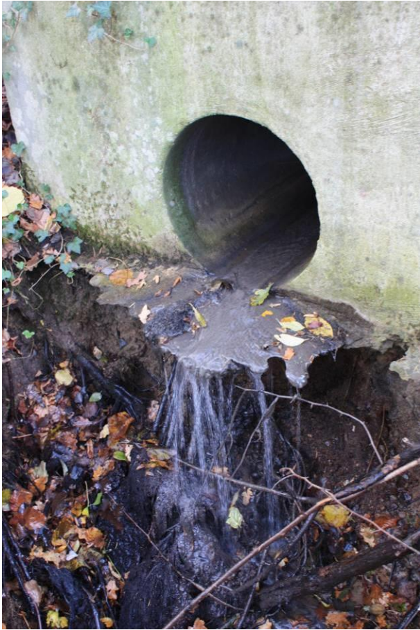
Abbildung 11: Lagepunkt 2 – Detailaufnahme des Abwasserauslaufbereichs
