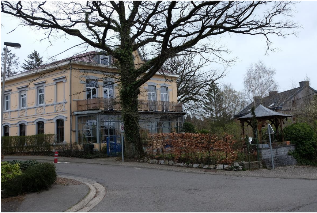
Abbildung 18: Sicht von Hochheid auf die Villa „Waldburg“, Hausterstraße 2, Hergenrath
