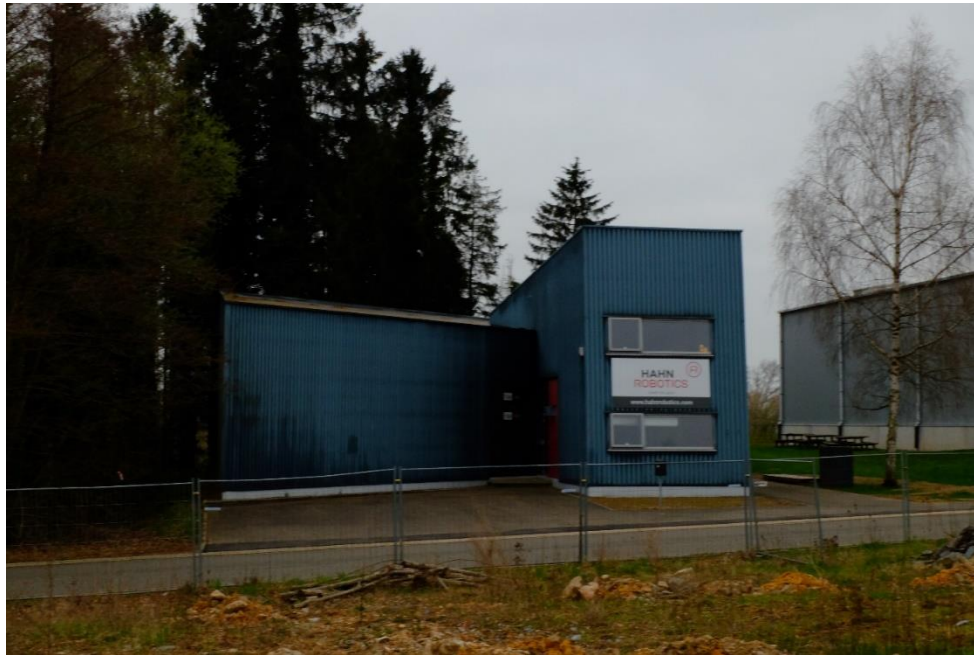
Abbildung 11: Straßenansicht des Unternehmens Hahn-Robotics im Hochheid in Hergenrath
